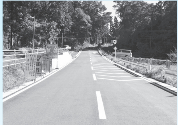
早期完成が待たれる本佐倉地先の町道 02-011 号線
