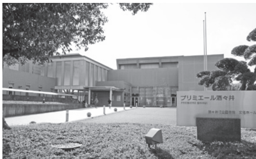
増築工事予定のプリミエール酒々井
