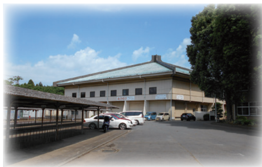
酒々井中学校屋内運動場大規模改修工事（施工前）
