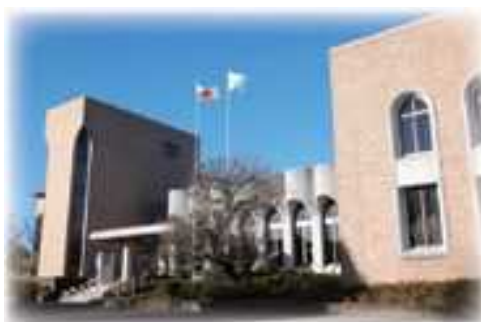
耐震補強工事が完了した中央公民館
