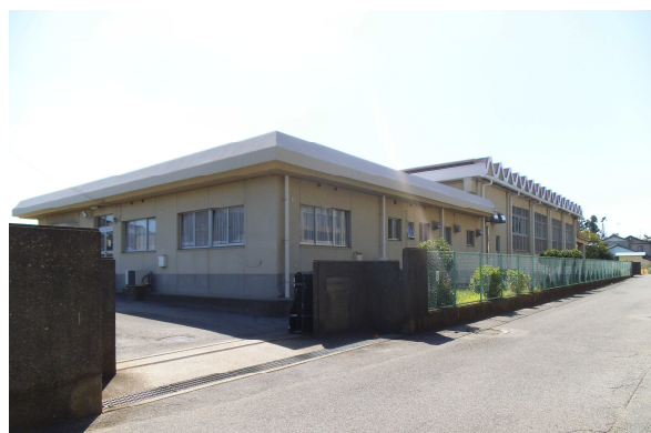
センター正面入口
