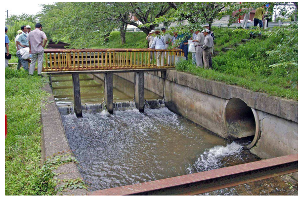
10 中崎橋の上流部
