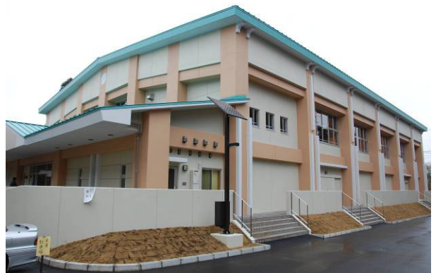
耐震化が図られた「酒々井小学校体育館」
